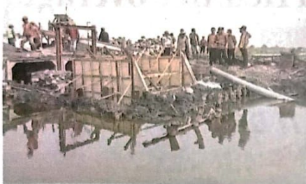
ANTISIPASI BANJIR TAHUNAN: Bupati Sidoarjo Ahmad Muhdlor Ali meninjau pembangunan rumah pompa di Desa Banjarasri, Kecamatan Tanggulangin, Sidoarjo, kemarin.
