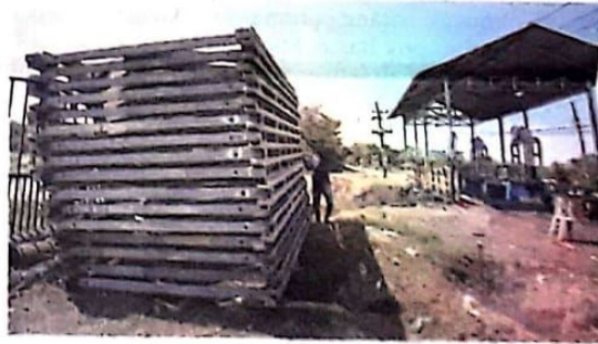
PROSES DISTRIBUSI: Material jembatan bailey ditumpuk di dekat jembatan Kedungpeluk yang akan dirakit tiga hari ke depan, kemarin (25/7).
