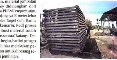
PROSES DISTRIBUSI: Material jembatan bailey ditumpuk di dekat jembatan Kedungpeleh yang akan dirakit tiga hari ke depan, kemarin (25/7).
