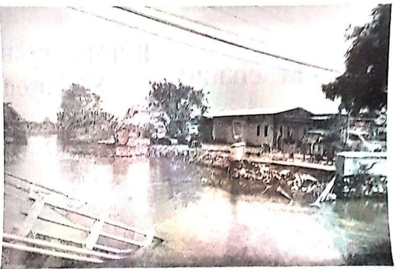
Kondisi Jembatan Kedungpeluk Kec. Candi, Kab. Sidoarjo yang ambrol.
